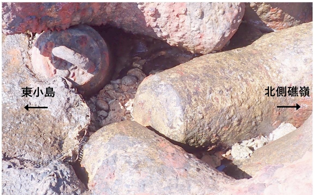
図 16 東小島の消波ブロックの間に堆積するサンゴ砂礫(上：小島南側，下：小島北側).
